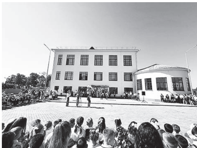
Школа в Лакинске после капремонта
