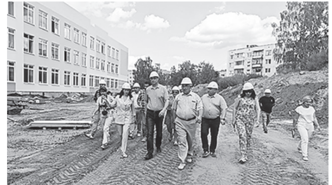
Губернатор А. Авдеев инспектирует ход строительства школы в Коврове, август 2023 года
