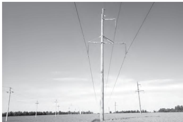
Новые сборные железобетонные опоры обладают высокими показателями механической прочности и могут выдерживать порывы ветра до 30 м/с. Конструктивная их особенность значительно упрощает процесс монтажа. Для транспортировки секций к месту установки не требуется специальная длинномерная техника и разрешение на провоз крупногабаритного груза по автомагистралям.
