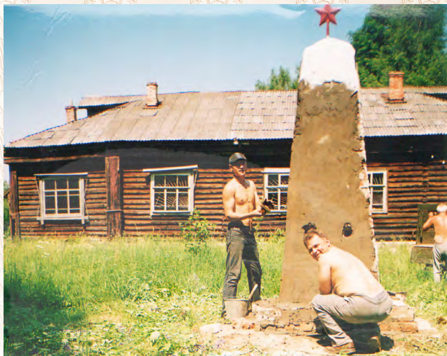
Ремонт Обелисков к Дню Победы
