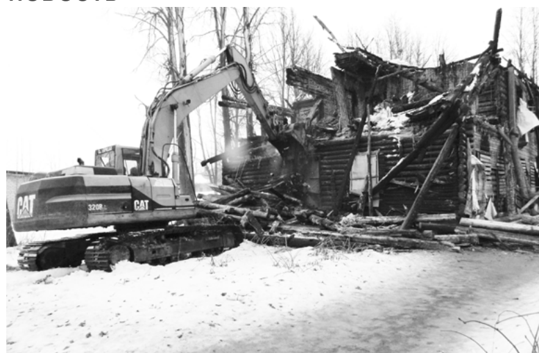
Кольчугинская транспортная компания» — начался демонтаж дома, который завершился 6 марта.
